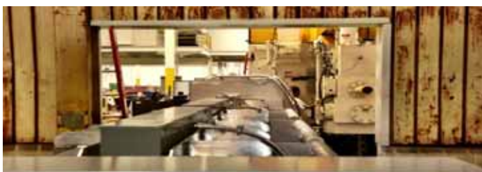
Artesa de metal fundido atravesando la pared
